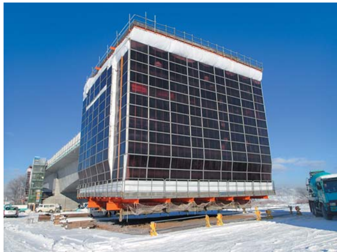
写真-1 PC橋の冬期施工現場
