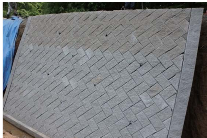
写真-6 ブロックの施工状況
