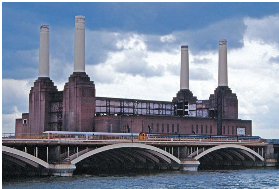
写真-3 バターシー発電所(左)とワンズワース区のサイン(1997年撮影)
