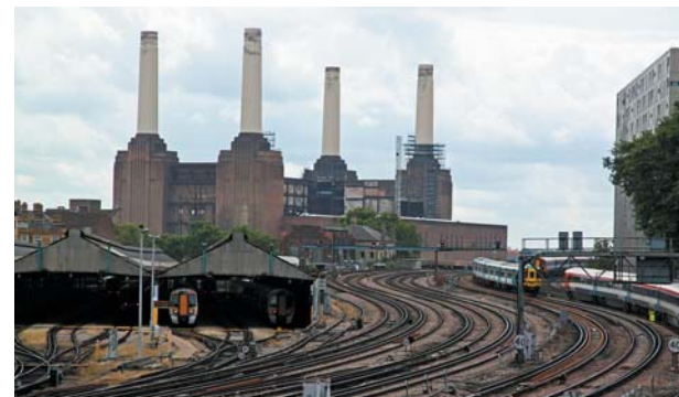
写真-4 エバリー橋から捉えたバターシー発電所(2012年撮影)
