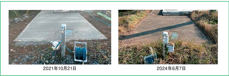
写真-3 施工後と約2年8カ月後の状況
