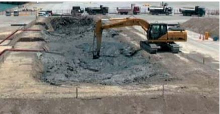
写真-1 試験施工の現場写真
