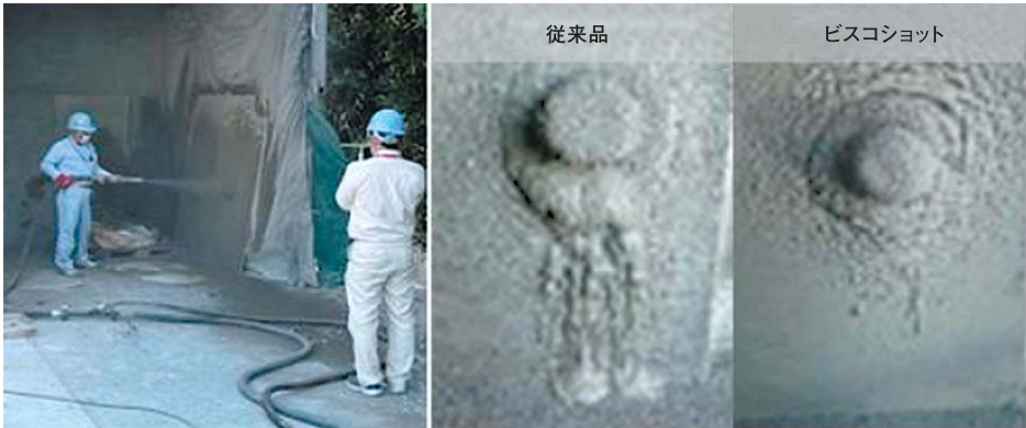
写真-2 実機モルタル吹付けの様子および付着状況
