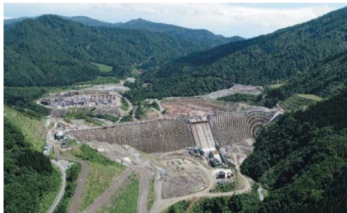
図-2 成瀬ダム全景 2025(令和7)年6月下旬
