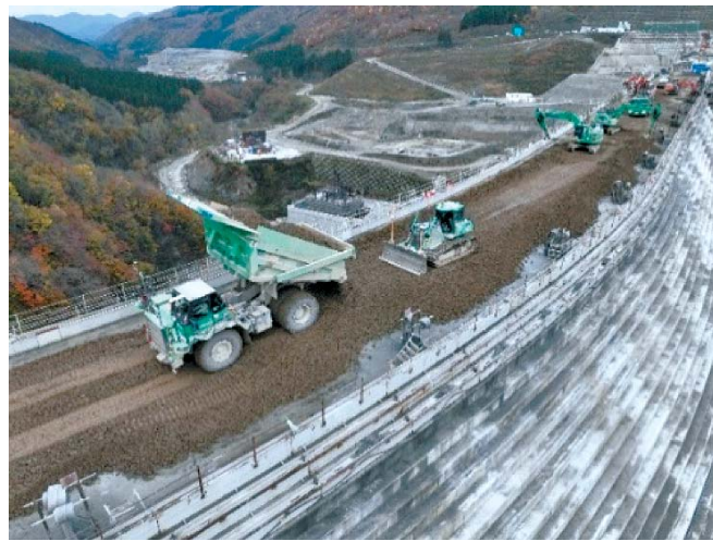
図-11 フライアッシュCSG打設状況
