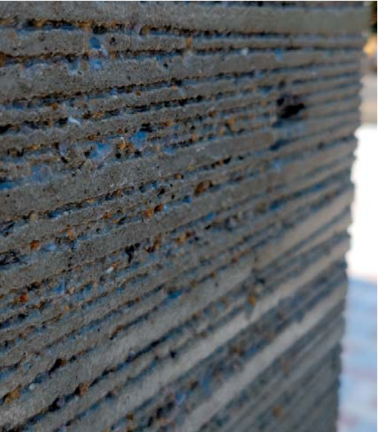
写真-5 ウォータージェット加工したコンクリートの表面
