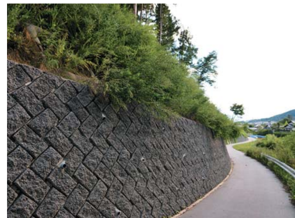
写真-3 スプリットンブロックのカーブ施工
