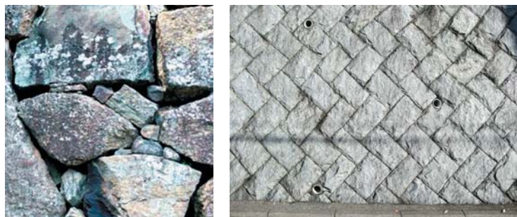
写真-2 天然石を用いた石積擁壁(左:乱積み 右:谷積み)
