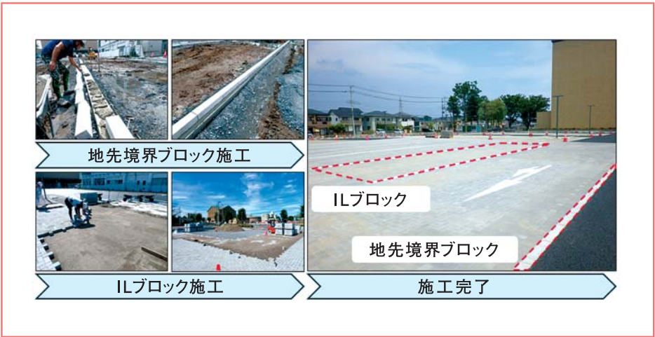
写真-3 施工時の様子
