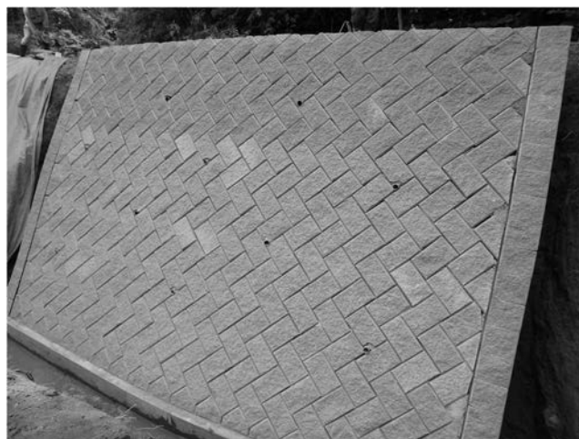
Fig.15 Installation status of SP blocks using CARBOFIX cement (カーボフィクスセメントを使用した SP ブロックの設置状況)
