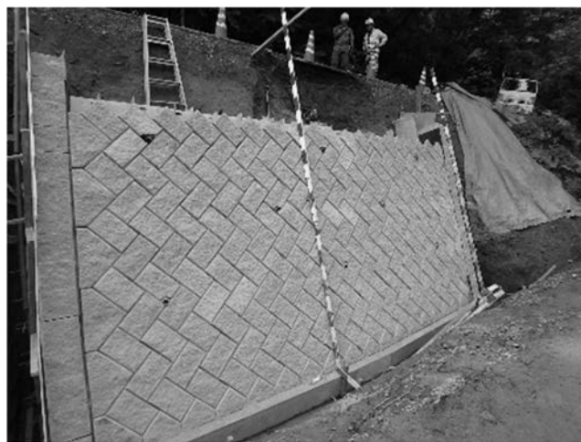
Fig.14 SP block installation status (SP ブロックの設置状況)
