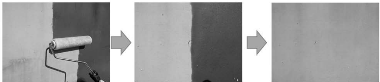
Fig.1 Condition after Clean Saver application (クリーンセイバー塗布後の状況)
