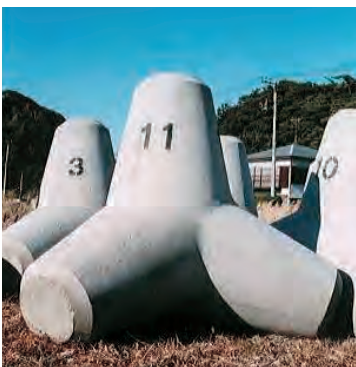
海岸設備（消波ブロック）
