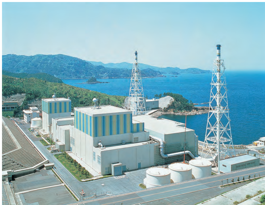
島根原子力発電所
