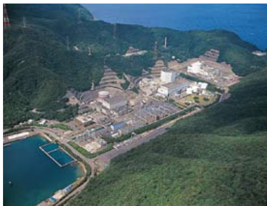
敦賀原子力発電所
