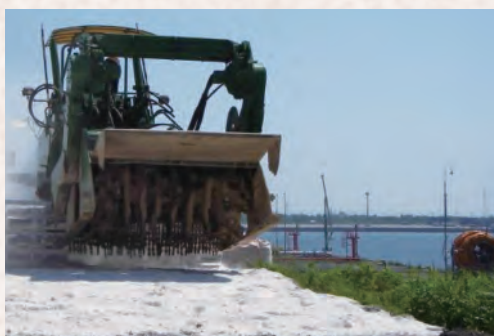
▲スタビライザによる施工状況(粉体添加)
