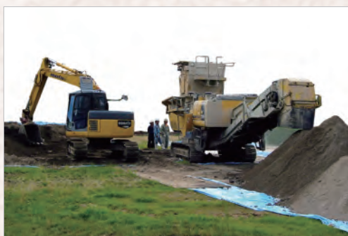
▲自走式土質改良機による施工状況(粉体添加)
