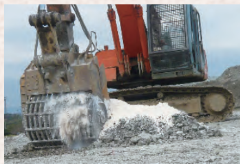
▲バケットスタビライザによる施工状況(粉体添加)
