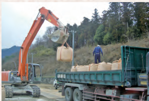
▲荷姿フレコンでの納入状況
