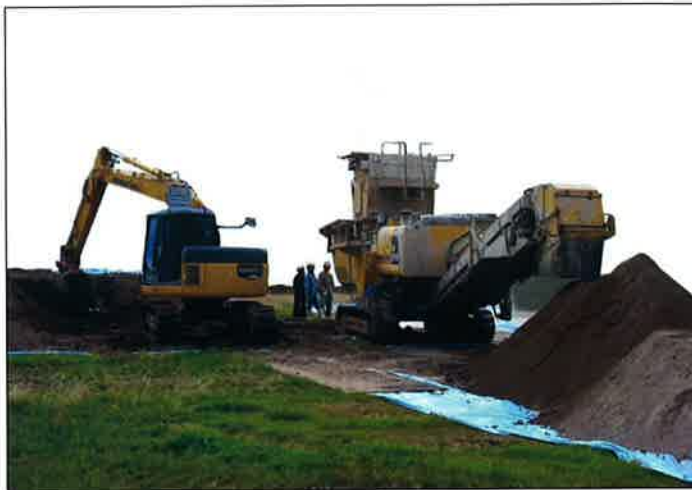
(写真-3) 自走式改良機を用いた施工状況 (粉体添加)
