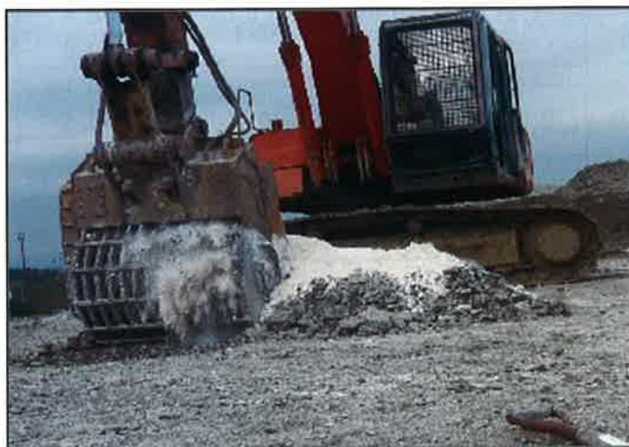
(写真-7) バケットスタビを用いた施工状況 (粉体添加)
