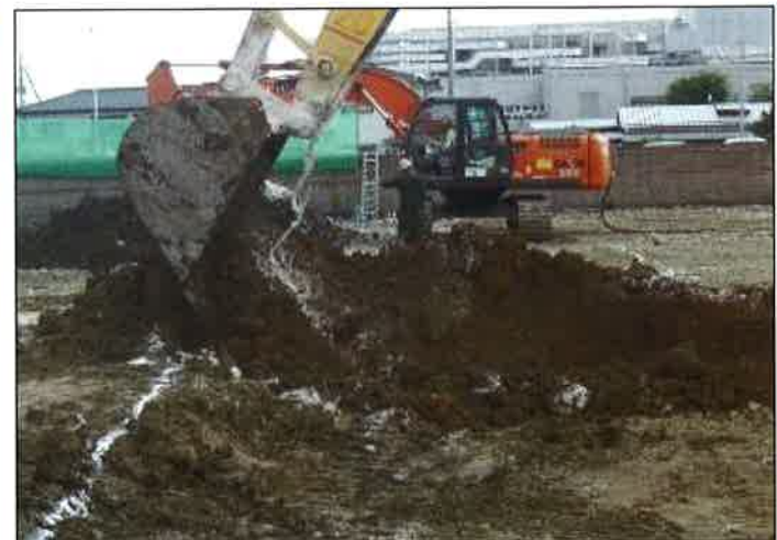
(写真-8) バックホウを用いた施工状況 (スラリー添加)
