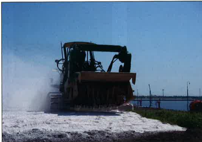
(写真-5) スタビライザを用いた施工状況 (粉体添加)
