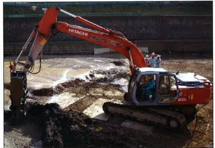
(写真-6) トレンチャーを用いた施工状況 (スラリー添加)
