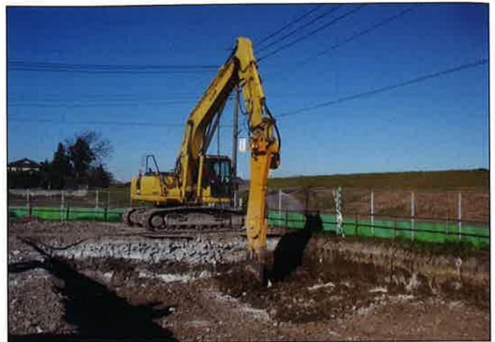
(写真-4) 特殊攪拌機を用いた施工状況 (スラリー添加)
