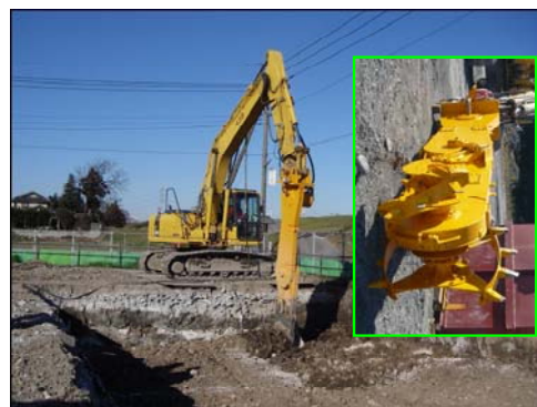
写真-1 施工状況
