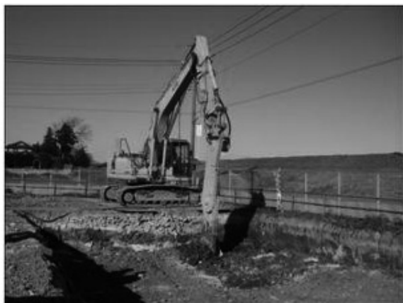
写真-1 サイトA 施工状況
