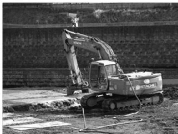
写真-2 サイトB 施工状況
