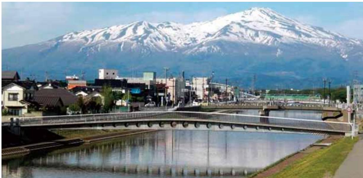
日本初の超高強度繊維補強コンクリートを用いた歩道橋である“酒田みらい橋”は2002年の竣工から18年(2020年1月現在)を迎えました。長期の耐久性確認のため、10年目、15年目経過時に各種試験を実施し、高い耐久性を有していることを確認しております。
