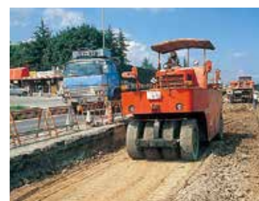
改良手順5 (転圧)
