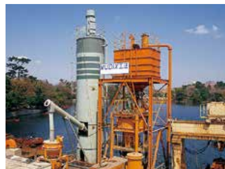
MUDIX工法(プラントによる)
