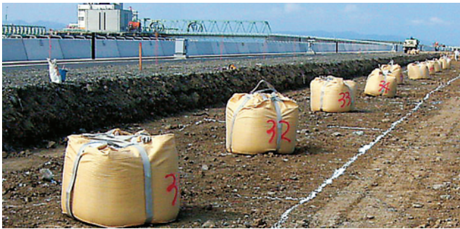
固化材(フレコン)の配置状況
