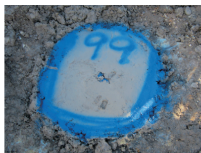
改良体杭頭の確認
