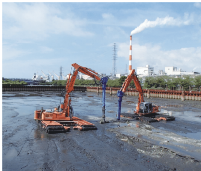
泥上車による改良状況
