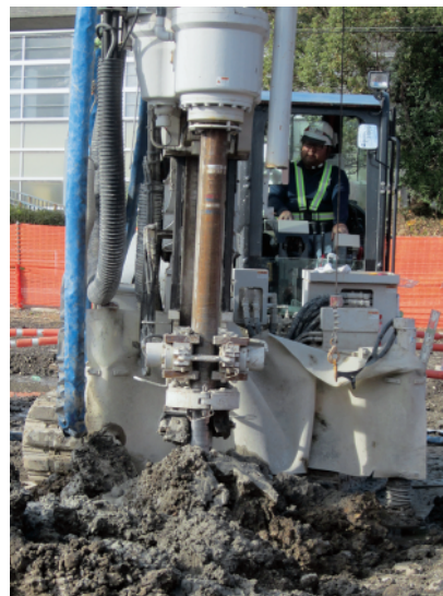
柱状改良による施工状況
