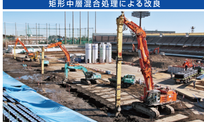
矩形中層混合処理による改良
