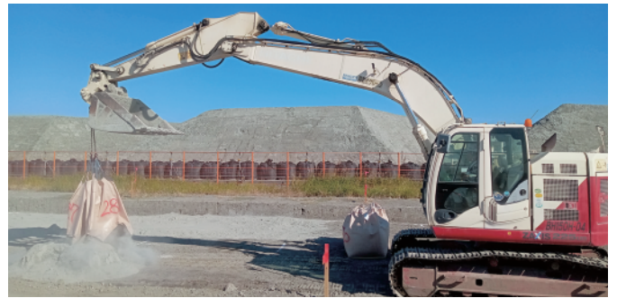
固化材(フレコン)の散布状況
