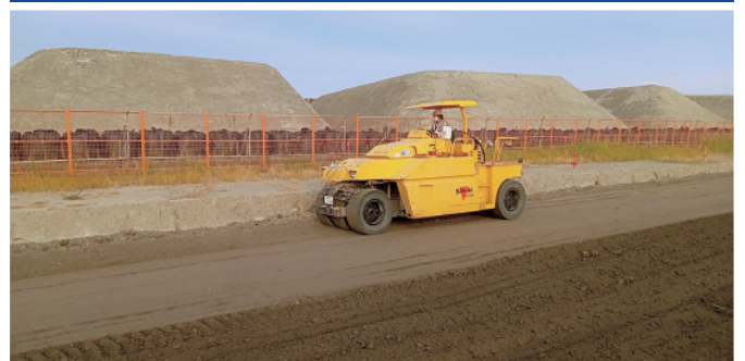
ローラーによる転圧
