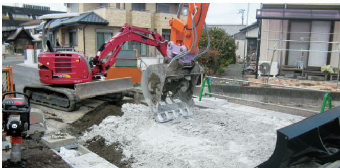
混合機付きバックホウによる混合
