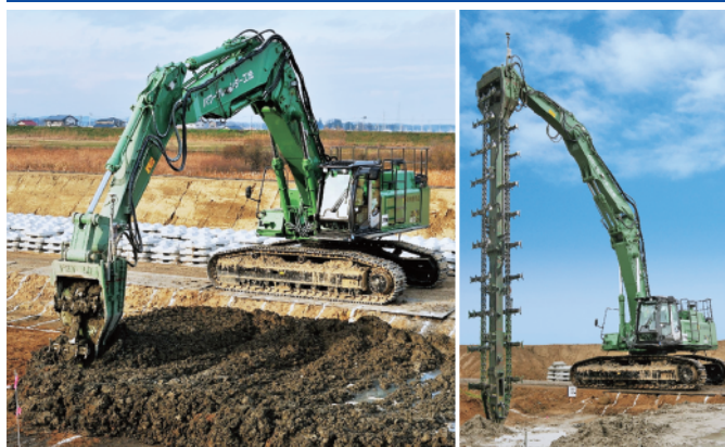
トレンチャ式攪拌混合機による改良
