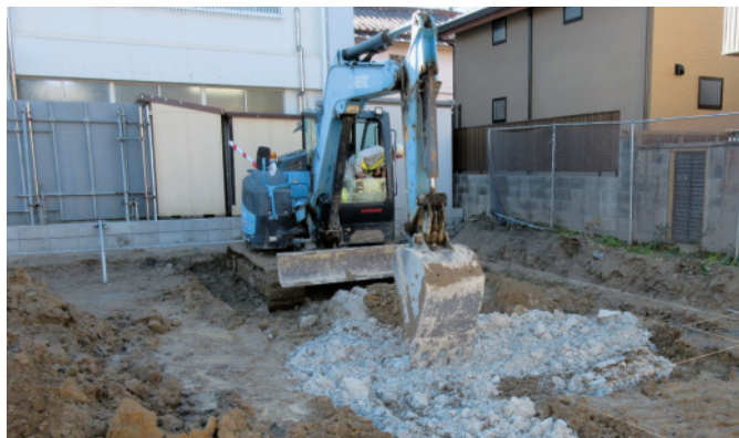
バックホウによる敷均し状況(使用固化材:防塵型固化材)
