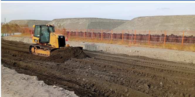
ブルドーザーによる整正
