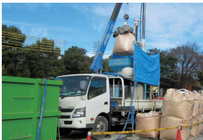
固化材(フレコン)投入状況
